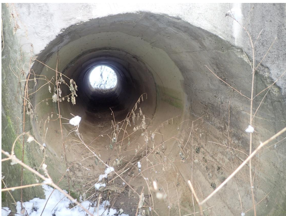
Foto 4: Nesouosost trub propustku, degradace betonu trub
