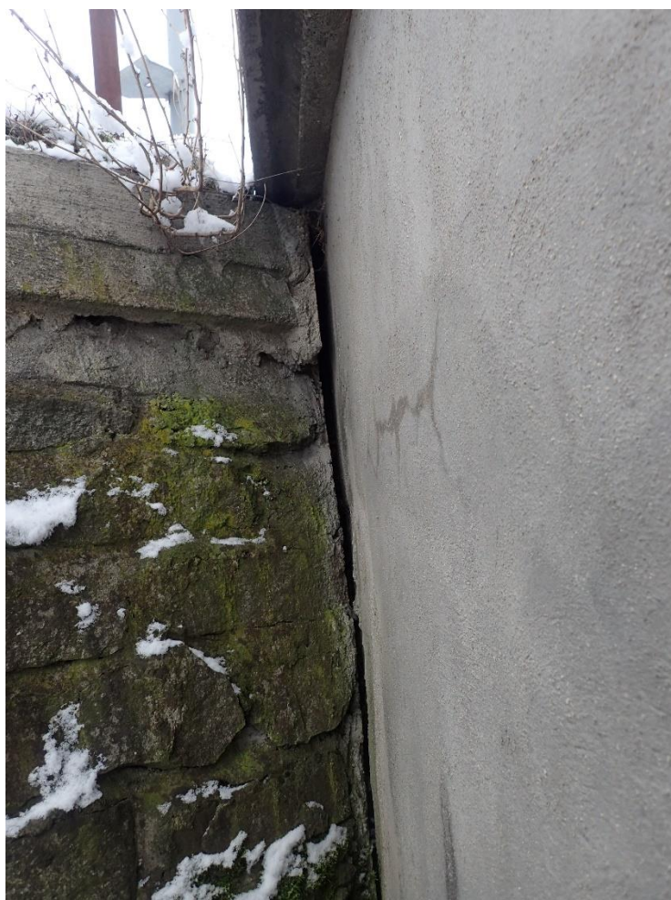
Foto 6: Spára mezi křídlem a čelem propustku
